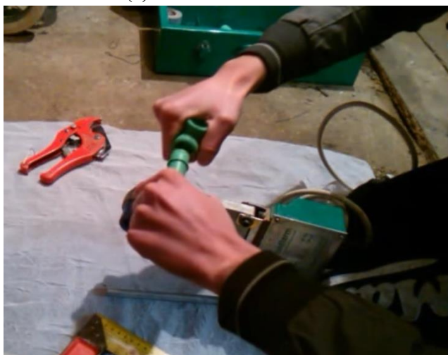
Slika br. 4. (e) Prikaz postupka izvlačenja djelova cijevi i spajanja istih; (f) Kontrola i nastavak rada
